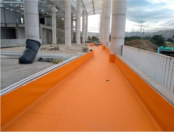
De acuerdo a su uso se debe instalar geotextil NT 1600 o más bajo la membrana como capa separadora y sobre la membrana como capa protectora de la impermeabilización.
